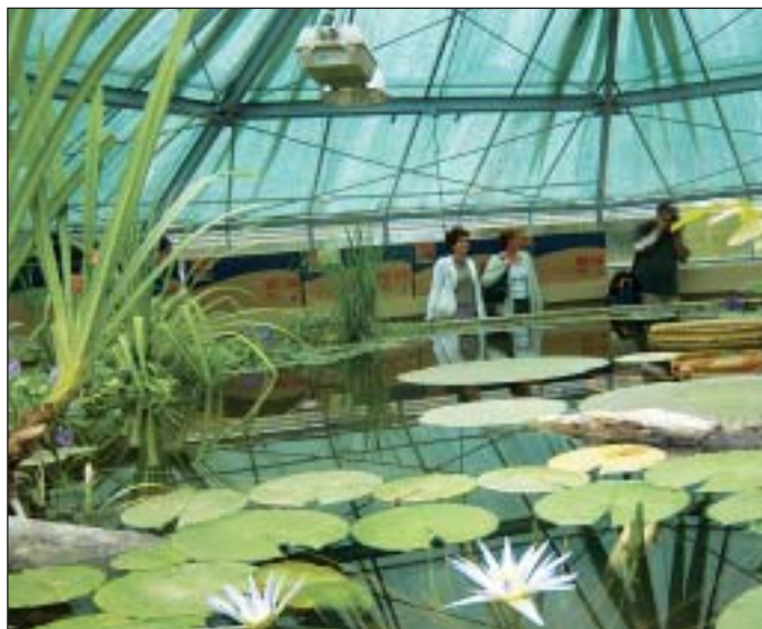
A felújított Viktória-ház belülről
