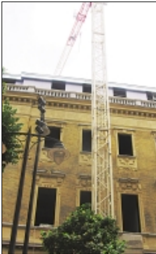
10-15 régi ház homlokzata újulhat meg
